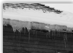
brak ogrzewania systemu rynnowego
