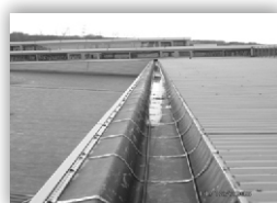
system ogrzewania rynny wewnętrznej
